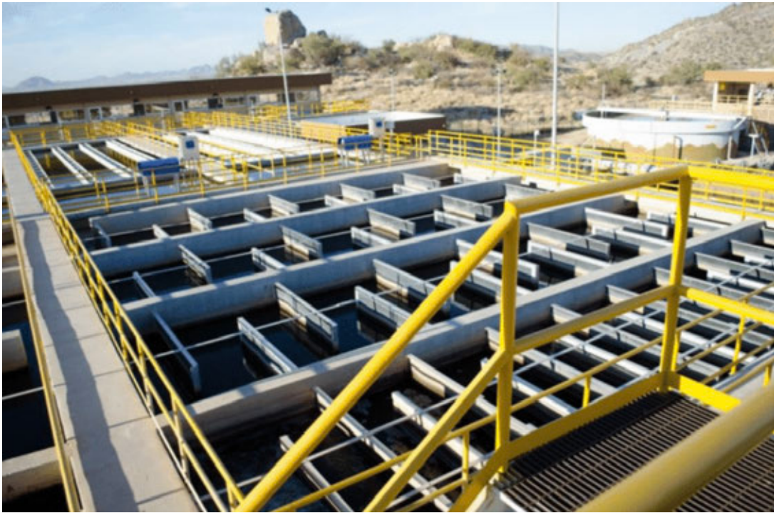
Figura 2. Planta potabilizadora del Cerro de la Piedra Bola, procesa agua proveniente de la presa "El Novillo"
